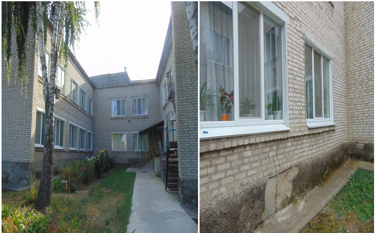
Рис. 5.1. Дошкільний навчальний заклад №1 «Пролісок»
